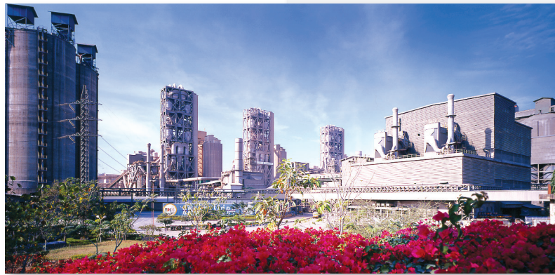
TPI Polene Cement Factory at Saraburi Province TPI Polene 水泥工厂 北标府
